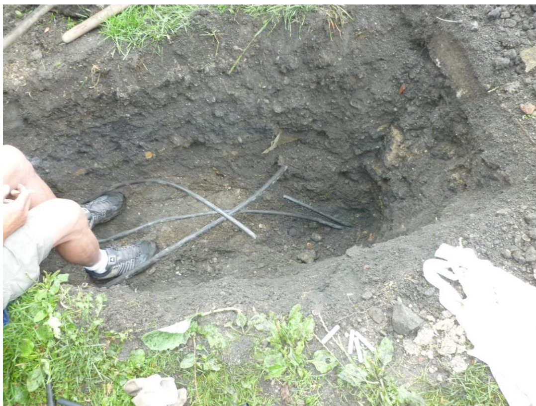
Obrázek 4 – Příprava na kabelovou spojkou
